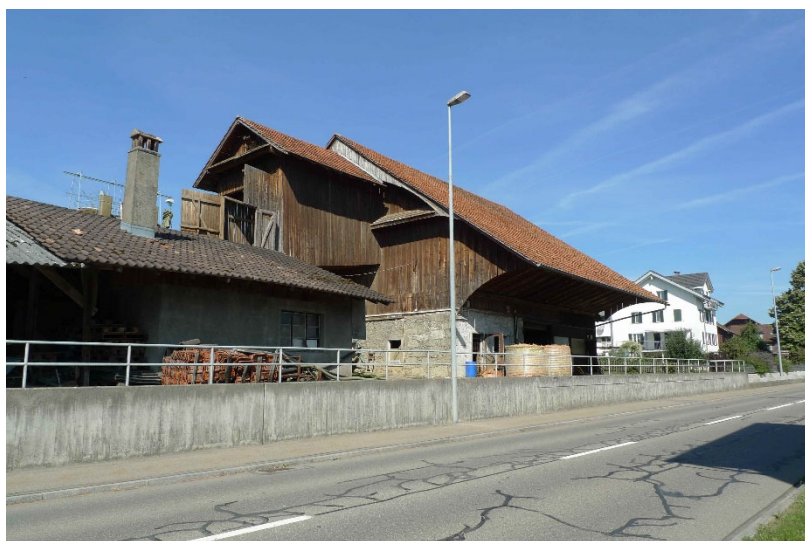
Ansicht von Südosten (2018)
