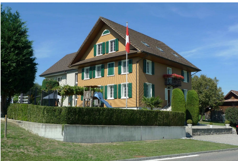
Ansicht von Südosten (2018)
