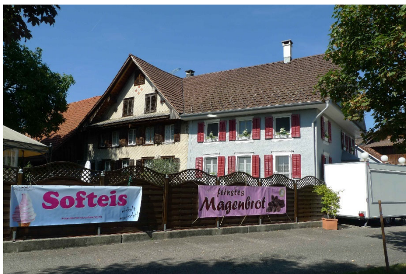
Ansicht von Südosten (2018)
