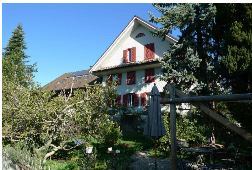
Ansicht von Südosten (2018)
